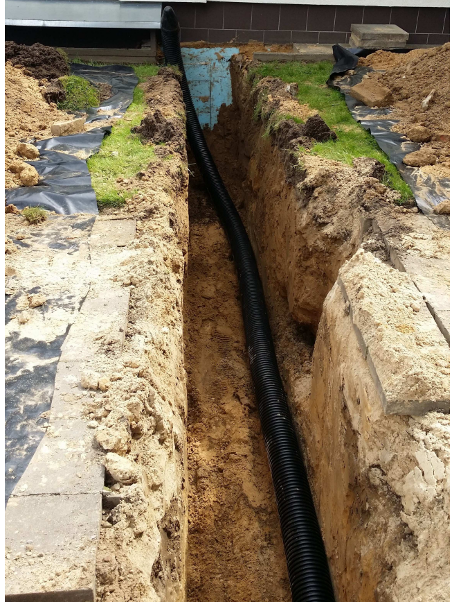
21. Šiluminė trasa ties pensiono pastatu. Vaizdas iš ŠV.
